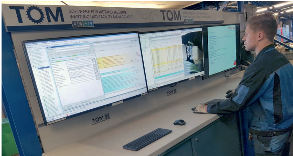
Die Überwachung und Steuerung des Anlagenbestands erfolgt am TOM-Terminal. Mehr als 10.000 Reparaturaufträge pro Jahr werden über das Störmeldeportal erfasst. Insgesamt arbeitet die Instandhaltungsabteilung 15.000 Arbeits-, Wartungs- und Reparaturaufträge pro Jahr ab.
